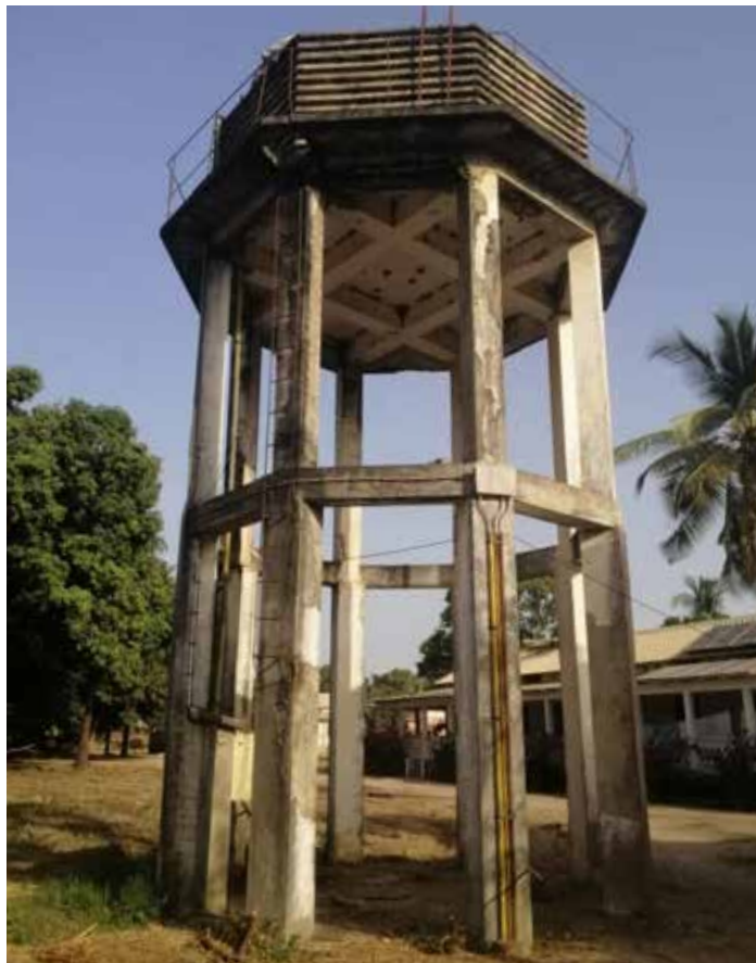
Acquedotto prima della restaurazione
